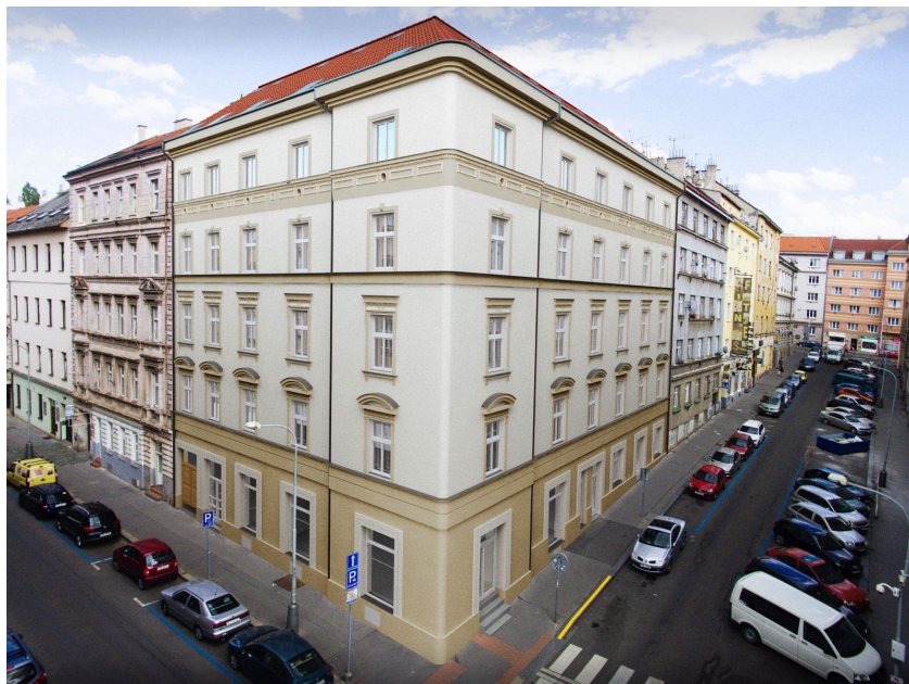
Činžovní dům Rezidence Palmovka - dokončeno (Rezidence Palmovka s.r.o.)
